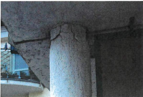
Zdj. 11 i 12 – Zdjęcia przedstawiające spękanie płyty balkonowej przy słupie okrągłym widoczne z balkonu na 2. piętrze w budynku przy ul. Duńskiej 38-44A – wizja lokalna z 28.09.2020r.
