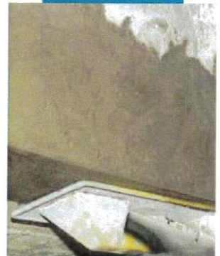
Naprawa krawędzi belek betonowych
