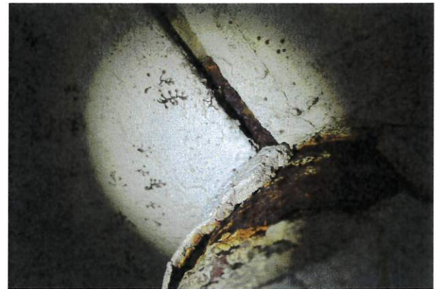
Zdj. 11 i 12 – Zdjęcia przedstawiające spękanie płyty balkonowej przy słupie okrągłym widoczne z balkonu na 2. piętrze w budynku przy ul. Duńskiej 38-44A – wizja lokalna z 28.09.2020r.
