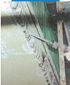
Naprawa gzymsów balkonowych: przygotowanie podłoża
