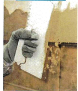
Naprawa gzymsów balkonowych: wygładzanie
