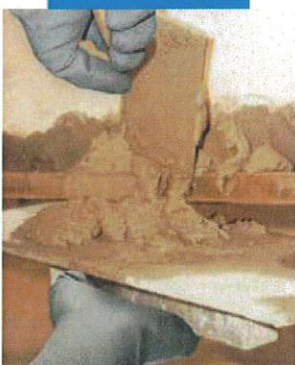
Naprawa gzymsów balkonowych: Nanoszenie Planitop 400
